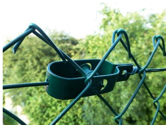
Detail napínací kladky k vypnutí drátu
