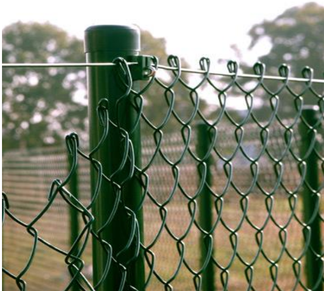
Háčkování zahradního pletiva k napínacímu drátu společně s detailem zatloukací přichytky
