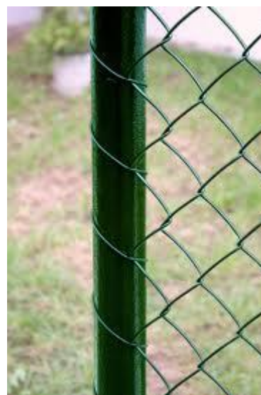
Přichycení pletiva vázacím drátem ke sloupku
