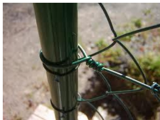
Detail ukončení napínacího drátu kolem sloupku
